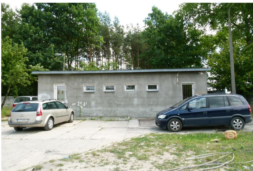
Ryc. nr 2. Widok budynku administracyjno-socjalnego na terenie składowiska.
