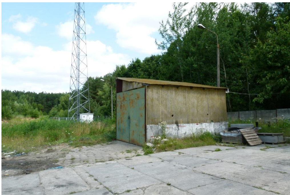
Ryc. nr 3. Pomieszczenie garażowe na sprzęt.
