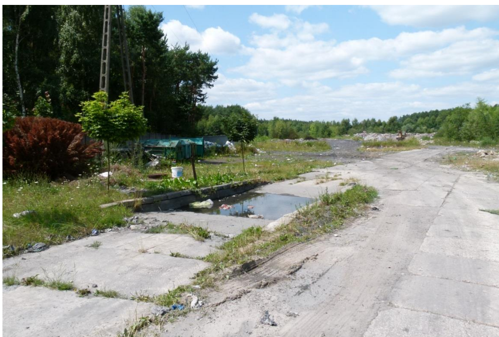
Ryc. nr 4. Widok drogi wewnętrznej z płyt drogowych do eksploatowanej kwatery oraz brodzik dezynfekcyjny.
