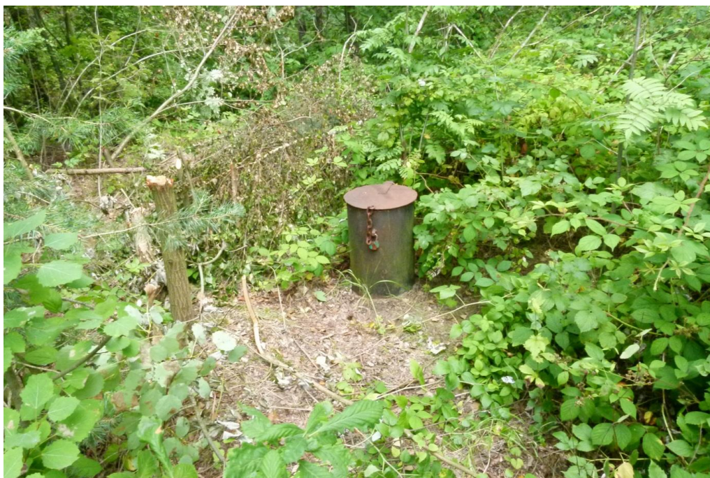
Ryc. nr 19. Widok piezometru P2 na napływie wód podziemnych zlokalizowanego w sąsiedztwie ogrodzenia terenu składowiska od strony wschodniej.
