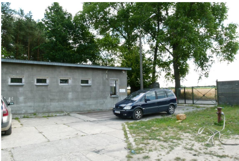
Ryc. nr 1. Widok z terenu składowiska – brama wjazdowa oraz waga samochodowa przy budynku administracyjno-socjalnym
