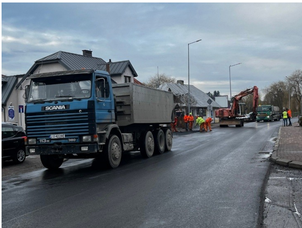
Foto 11. Remont ulicy Kazimierskiej. Źródło: Urząd Miejski w Beżycach.
