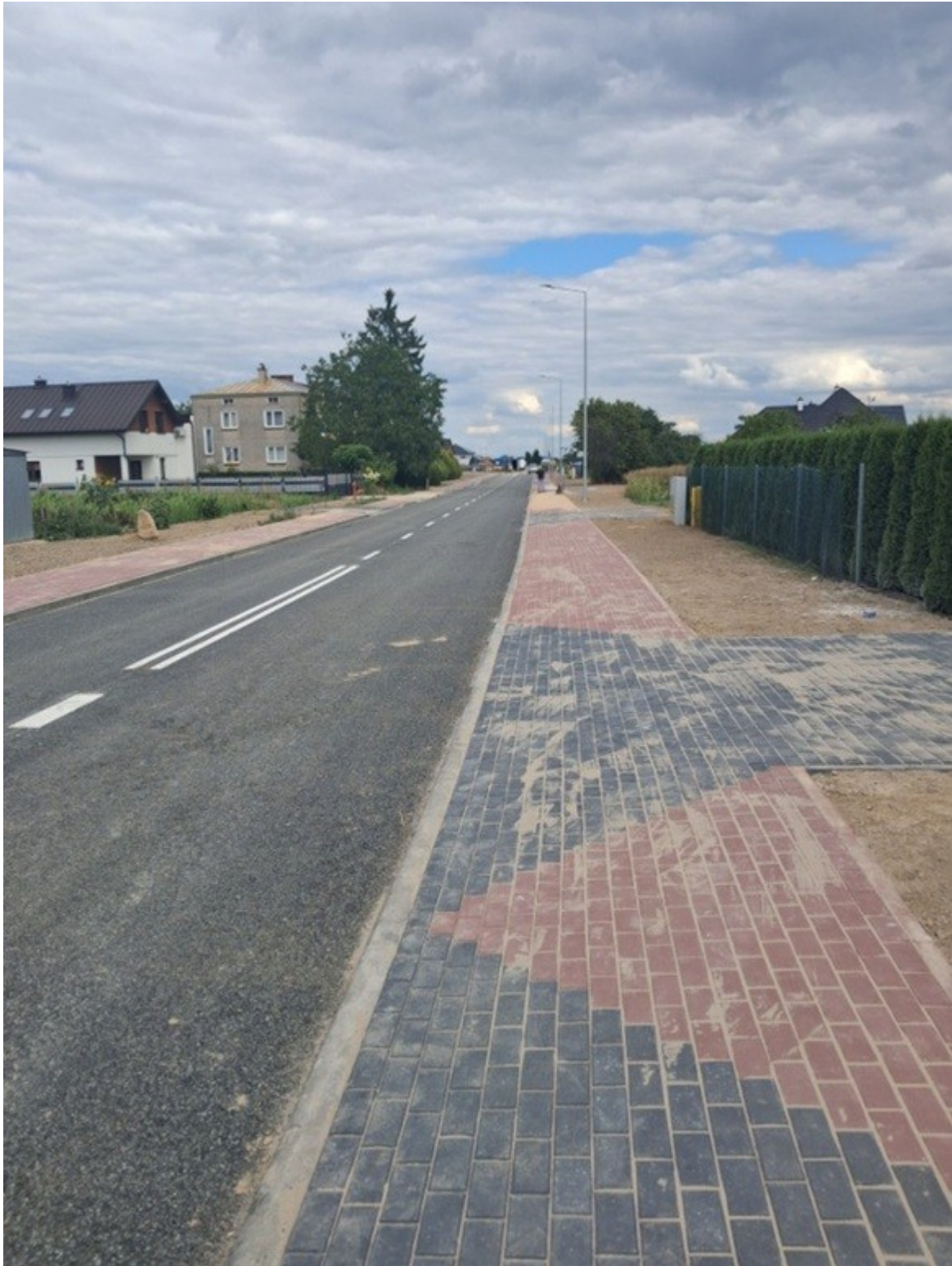
Foto 10. Budowa drogi gminnej ul. Wojska Polskiego. Źródło: Urząd Miejski w Beżycach.
