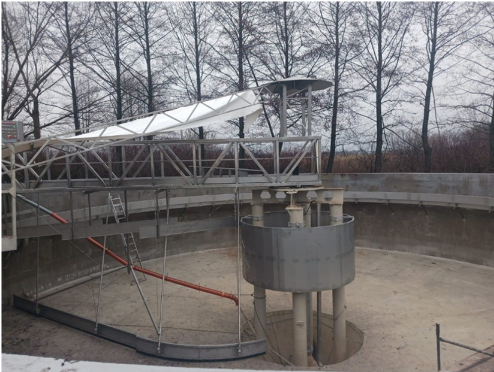
Foto 4. Modernizacja oczyszczalni ścieków w Beżycach. Źródło: Urząd Miejski w Beżycach.
