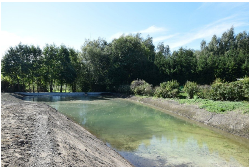
Foto 7. Przebudowa zbiornika naturalnego na zbiornik retencyjny w miejscowości Stare Wierzchowiska.
