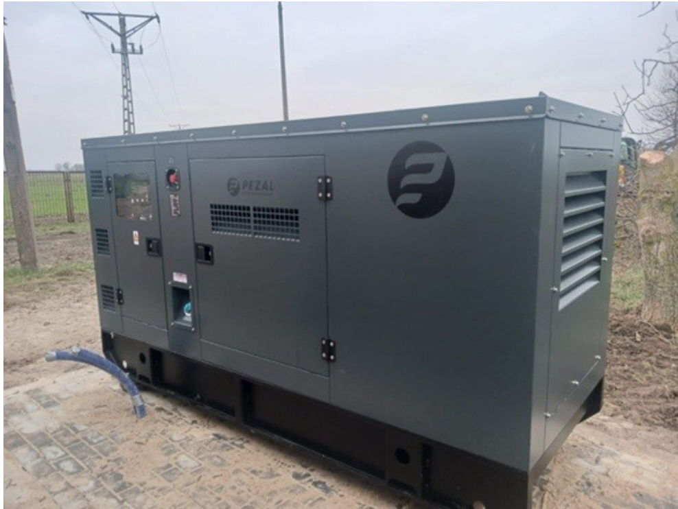
Foto 3. Modernizacja studni głębinowych na ujęciu wody w Beżycach. Źródło: Urząd Miejski w Beżycach.
