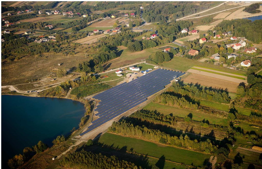
Widok farmy słonecznej o mocy 1 MW w Wierchosławicach
