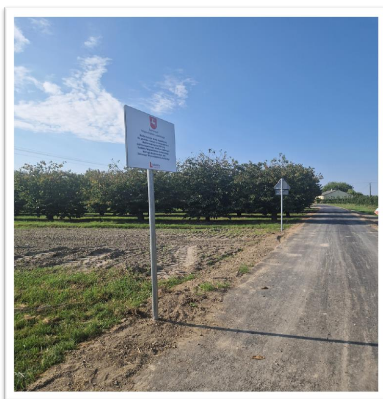
Fot. 2 Modernizacja drogi gminnej Nr 106994L w m. Malinowszczyzna.
