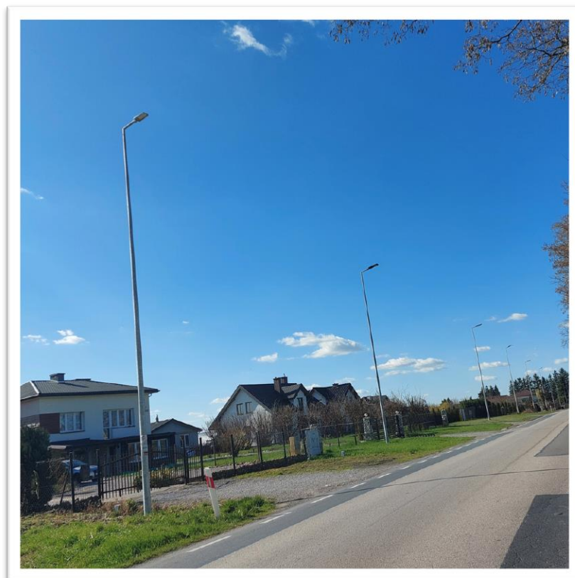
Fot. 5 Budowa oświetlenia drogowego w m. Podole Majdan. Źródło: własne.
