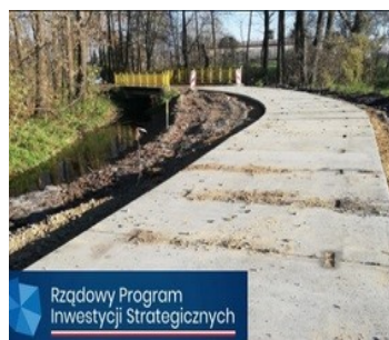
Rozbudowa drogi w Babinie
