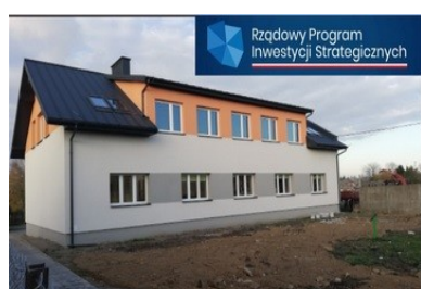
Przebudowa infrastruktury edukacyjnej
