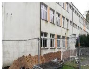
Przebudowa Szkoły Podstawowej Nr 1
