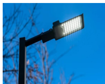
Budowa oświetlenia solarnego przy Pl. Powstańców Warszawy
