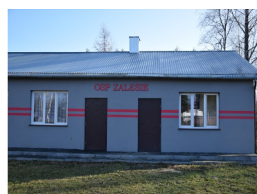
Modernizacja remizy OSP Zalesie
