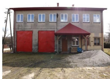
Modernizacja remizy OSP Stare Wierchowiska
