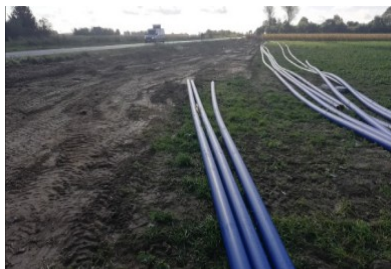
Budowa wodociągu i kanalizacji w ul. Przemysłowej
