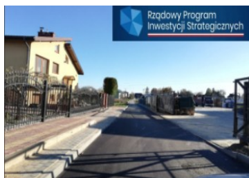
Przebudowa dróg, placów, chodników w centrum Bełżyc
