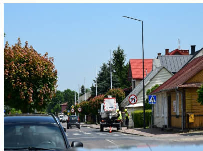
Modernizacja oświetlenia ulicznego na ul. Lubelskiej
