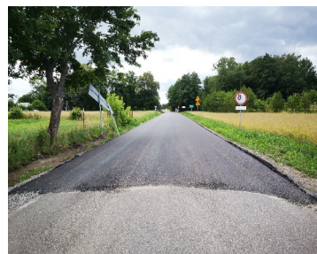
Przebudowa dróg powiatowych
