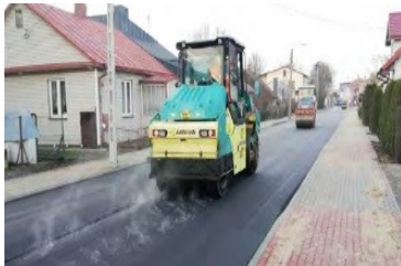
Przebudowa dróg gminnych w centrum
