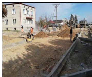
Przebudowa dróg gminnych
