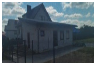
Budowa świetlicy Płowizny
